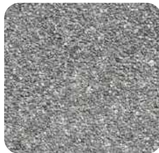
Покрытие из щебня мелкой фракции
