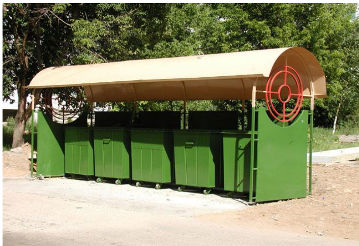
Рис. 4.21. Контейнерная площадка ОК-ОГ-001 фирмы ООО «Сезам-Д»
